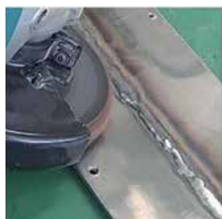
Limpieza en cordones de soldadura
