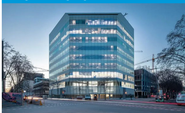
Hexagon Building 22@ Oficinas
