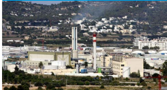
Central térmica GESA
